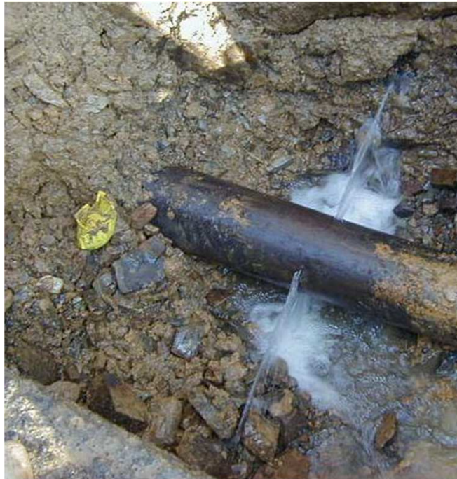
Leckage- und Rohrbruchbeseitigung
